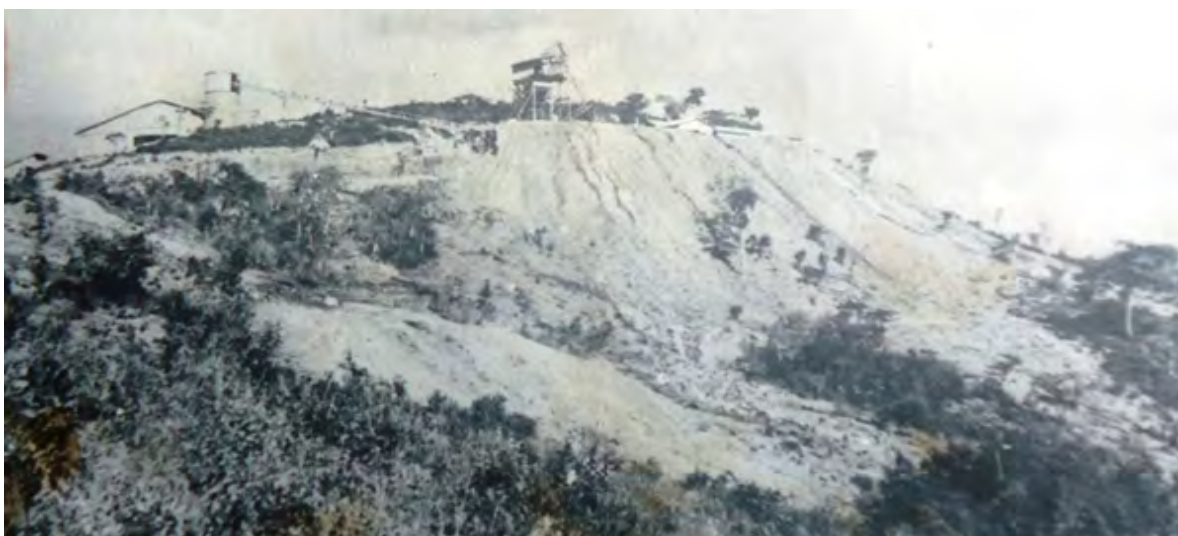
FIGURA 2. La imagen panorámica pancromática de 1955 muestra la elevación que da nombre al prospecto minero Los Cerros. En ella aparecen las instalaciones de la mina (al centro), la planta de procesamiento y concentración del mineral (a la derecha) y la ladera desnuda y afectada por el vertimiento de escombros. Tomado de Compañía Minera Los Cerros SA, (1955). Fotocopia por Ramón O. Pérez Aragón, 2014
