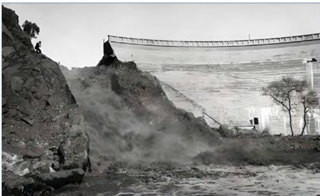
FIGURA 1. Fallo de la cortina de una presa (Archivo del autor). Szymansky y Davies han señalado que “Cualquier ingeniero que juzgue que una presa es estable a largo plazo simplemente porque ha sido aparentemente segura durante un largo período de tiempo ... está cometiendo un error de juicio potencialmente catastrófico...”
