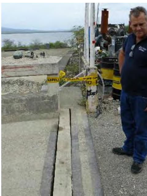
FIGURA 6. Desplazamiento del aliviadero de la Presa San Vicente como consecuencia del terremoto de abril de 2016. (Foto del autor)
